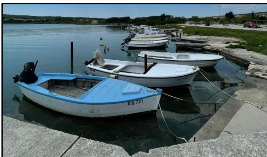
Slika 2.1-7. Pogled s betonskog mula na djelomično izbetoniran dio obale (izvor: Via factum d.o.o. , 2023.)
